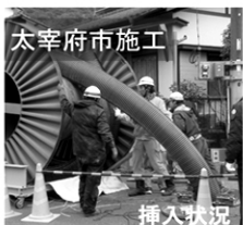
太宰府市施工 挿入状況
