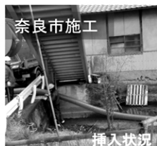
奈良市施工 挿入状況
