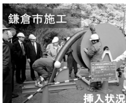
鎌倉市施工 挿入状況
