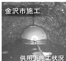
金沢市施工 供用中施工状況
