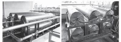
所在地が海に近く、地震に加えて津波対策が必要でした。津波による床上浸水に備え、3階(地上8.6M)のデッドスペースを選定。非常時の避難場所として、飲料水・衛生水・消毒水の提供源として活躍を期待しています。
