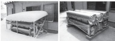
豪雪地帯に所在し、震災等の災害に加えて雪や寒冷への対応が必要でした。製品の保温対策、屋根による雪除け対策により2018年初の極寒、豪雪にも凍結もなく、継続して快適に利用しています。
